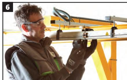
**5** Cubrir la conexión, colocar los empalmes RGMM02 (ambas mitades) (**Foto 6**) hasta su cierre completo (**click**) mediante las pestañas de presión (**Foto 7**).
