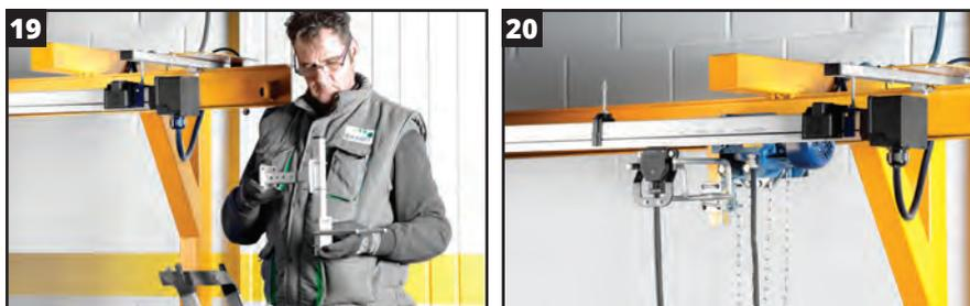
**9** Previo a realizar el conexionado a red de la línea verificar de modo manual que el carro colector se mueve sin dificultad a lo largo de la instalación, sin saltos, poniendo especial atención en las uniones entre barras.
