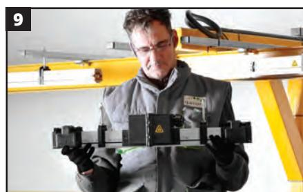
**6** La acometida eléctrica puede realizarse bien por un extremo de la línea, alimentación extrema (**Foto 8**) o bien puede realizarse la acometida en cualquiera de las uniones de tramos a lo largo de la instalación, alimentación intermedia (**Foto 9**).
