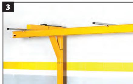
**3** Posicionar las barras conductoras atornillando los soportes deslizantes RGMM01 a los soportes universales (**Foto 4**). Es importante colocar todas las barras en la misma posición, es decir, la toma de Tierra marcada en el perfil de PVC, y la pegatina "RG" deben ir colocadas **SIEMPRE DEL MISMO LADO** (**Fotos 4 y 5**). La geometría interior del perfil PVC es asimétrica, de modo que el carro colector solo tiene una posición de colocación, evitando un posible intercambio de fases.
